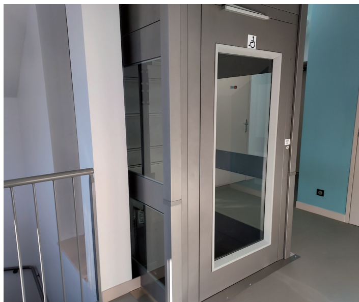
Réhabilitation des locaux de La 4C avec installation d'un ascenseur pour une accessibilité aux personnes handicapées.
