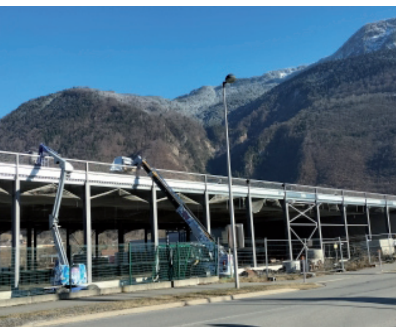
ZAE Les Grands Prés - Travaux d'agrandissement de l'Intermarché Saint-Etienne-de-Cuines
