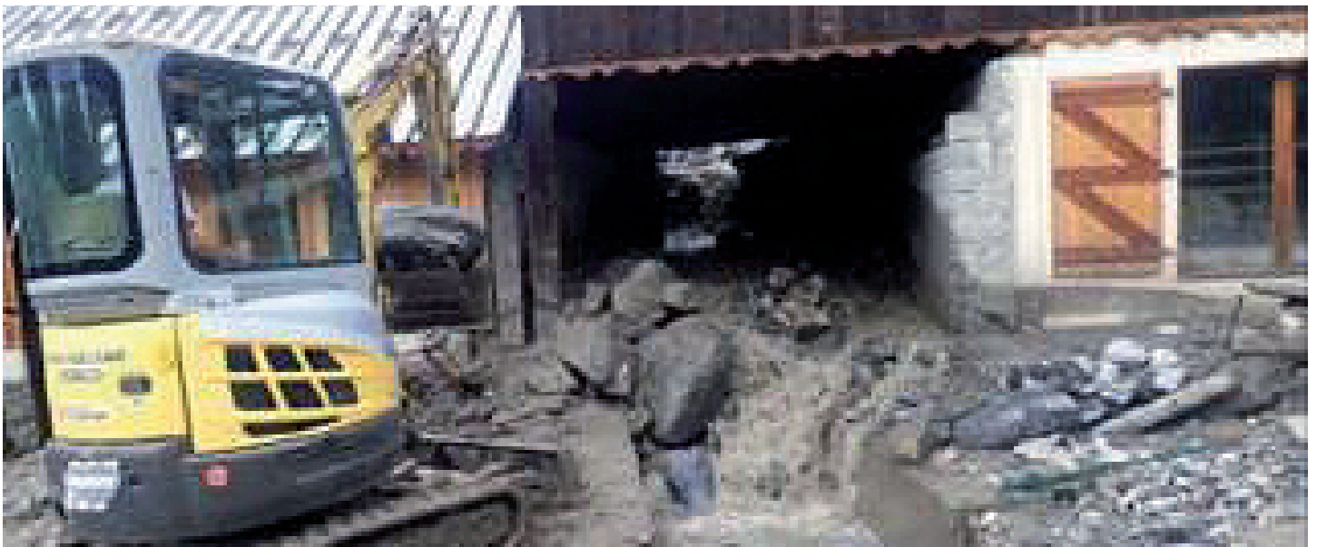
Travaux sur le Bugenet - Montaimont / Saint François Longchamp
