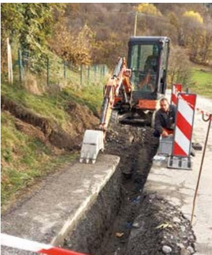
Face à cette situation, la Collectivité a décidé de créer un nouveau réseau entre le brise-charge de La Planche et La Scie, avec pose d'un regard et d'un compteur en limite de propriété des intéressés ; le raccordement depuis le compteur jusqu'à l'habitation restant à la charge des particuliers.
